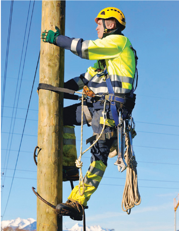
Freileitungsmonteur bei der Arbeit.
