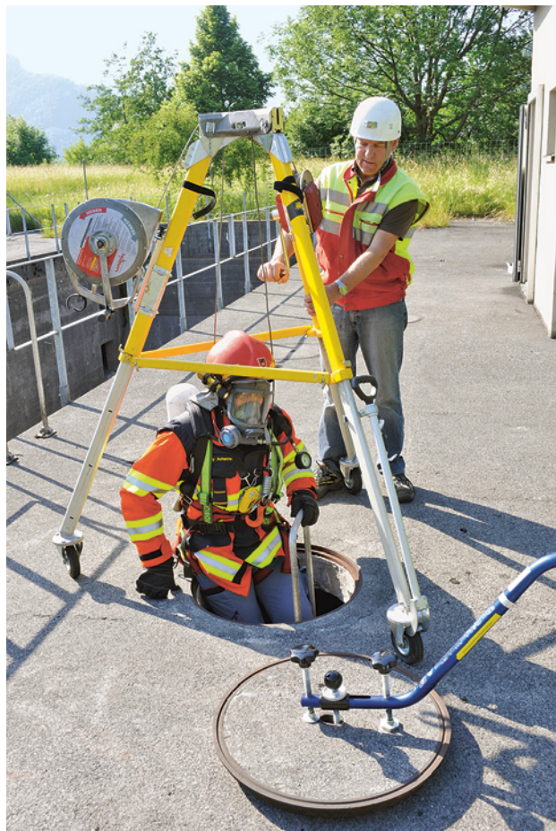
Beim Einstieg in einen Schacht wird die arbeitende Person durch eine zusätzliche Person überwacht.
