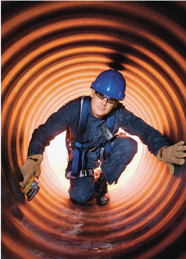
Bei Arbeiten in engen Räumen muss die eingestiegene Person dauernd überwacht werden.
